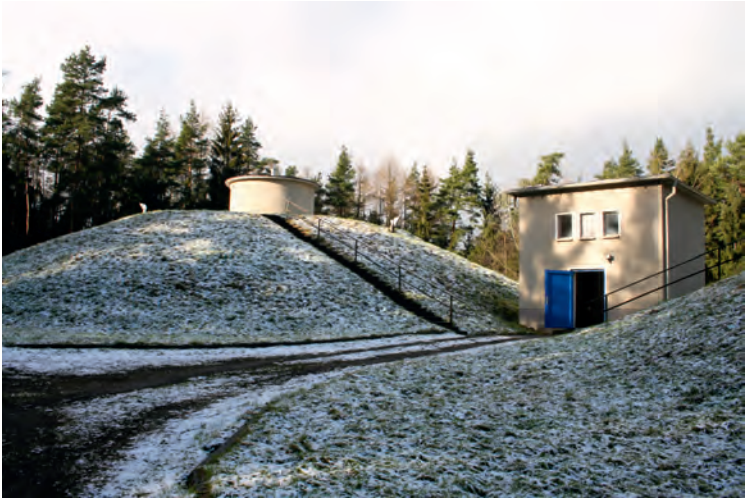
Der Trinkwasserhochbehälter Haardt wird 2013 erneuert.
