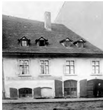
Altes Haus, Brüderstraße 16
