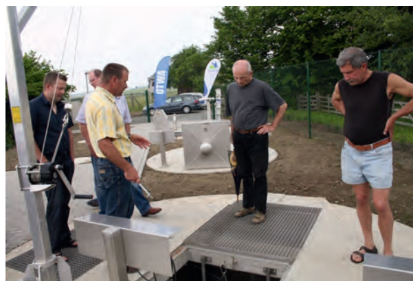
Zahlreiche Interessierte kamen zur feierlichen Inbetriebnahme der KA Teichwitz.
