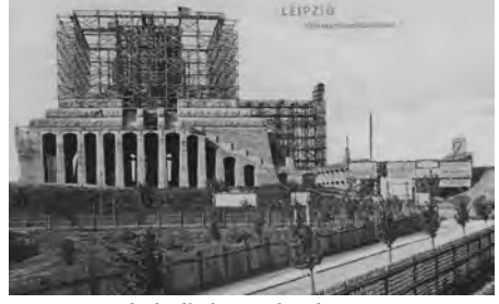
Das im Bau befindliche Denkmal
