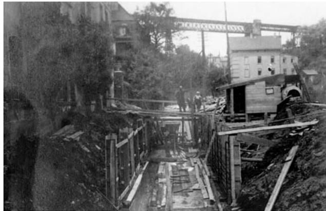
Der Oschützbach wird in einen überdeckten Kanal vom Oschütztal-Viadukt bis zur Steinschenke verlegt.
