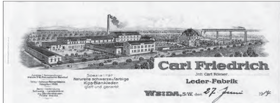
Abb. Leder-Fabrik mit Viadukt – Sammlung Walfried Schubert
