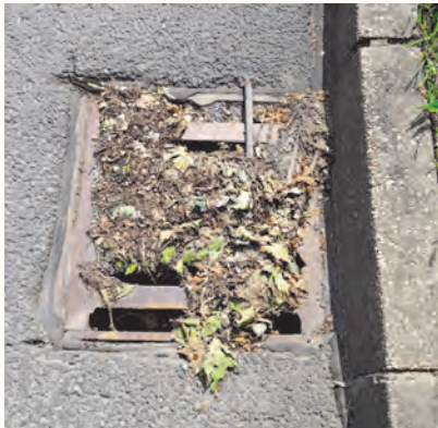
Zwei verschmutzte Regeneinläufe, wie sie oft zu finden sind. Wenn die Laubschicht (links) nicht beseitigt wird, verstopft sie zusätzlich den Ablauf. Beim Hineinschauen ist der Unrat im rechten Gully zu sehen. Fotos: Beck
