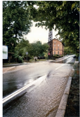
Foto: Hochwasser am 3. Juni 2013 des Oschütztbaches am Pfeiler IV des Oschütztal-Viaduktes.
