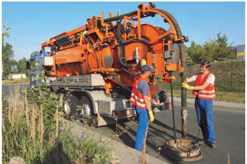
Das Beherrschen der komplexen Technik beim Einsatz dieses Spülfahrzeuges gehört auch zum Aufgabenspektrum der Fachkraft. Foto: ZVME
