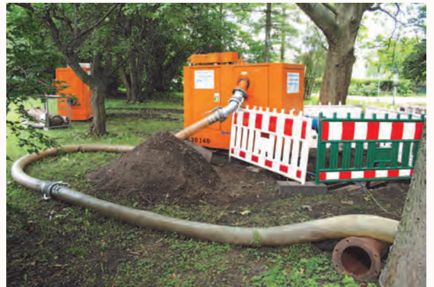
Die Pumpleitung wird mit Hilfe eines Dieselmotors betrieben (oben). Die Tiefe des Baufeldes ist im Bild links zu sehen. Foto: ZVME
