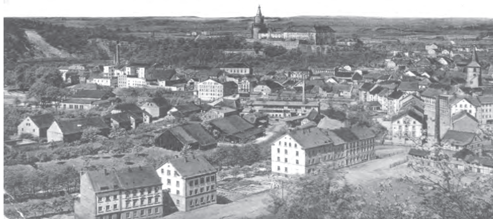
Blick vom Krippenberg auf die im Bau befindliche Turmstraße. Rechts im Bild die alte Gerberei.
