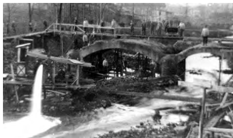
Brückenbaustelle in der Karolinenstraße 1926
