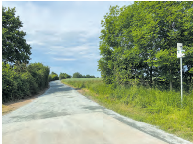
Osterburgroute – Alte Veitsberger Straße zwischen Weida und Wünschendorf
