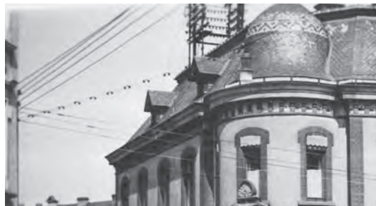
Dachständer für Telenetz.
